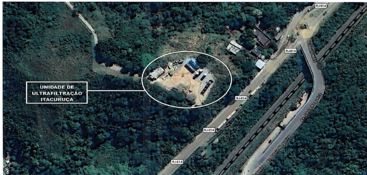
Imagem 03: localização da Unidade de Ultrafiltração Itacuruça.
