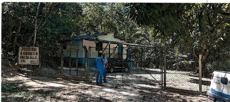
Foto 01 - Entrada da Unidade de Tratamento de Água Itinguçu.
